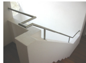
Brüstungs-Geländer CNS Zelgli, Aarau
