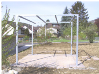
Pergola über Sitzplatz Erlinsbach
