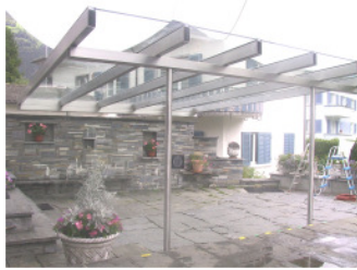
Sitzplatzüberdeckung aus CNS Schattdorf
